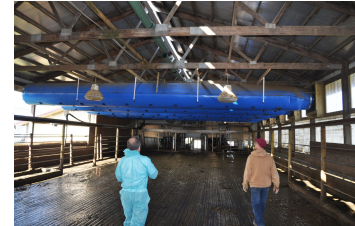
Amerikanske overtryksventilationsanlæg bringer frisk luft ind over køerne via rør eller kanalformede "poser". Klik på billedet og få det vist i stor størrelse.
